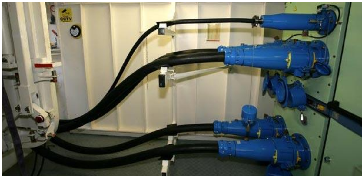
Slika 4.4: Brodski panel obalne veze s priključenim energetskim kabelima s kopna
